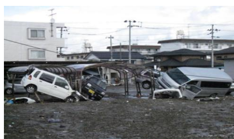
病院から 2Km 先、すさまじい津波被害
